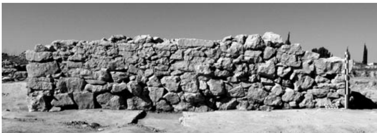
Fig. 39 : Détail du parement du mur frontal de la tour T4 (MR23195).
