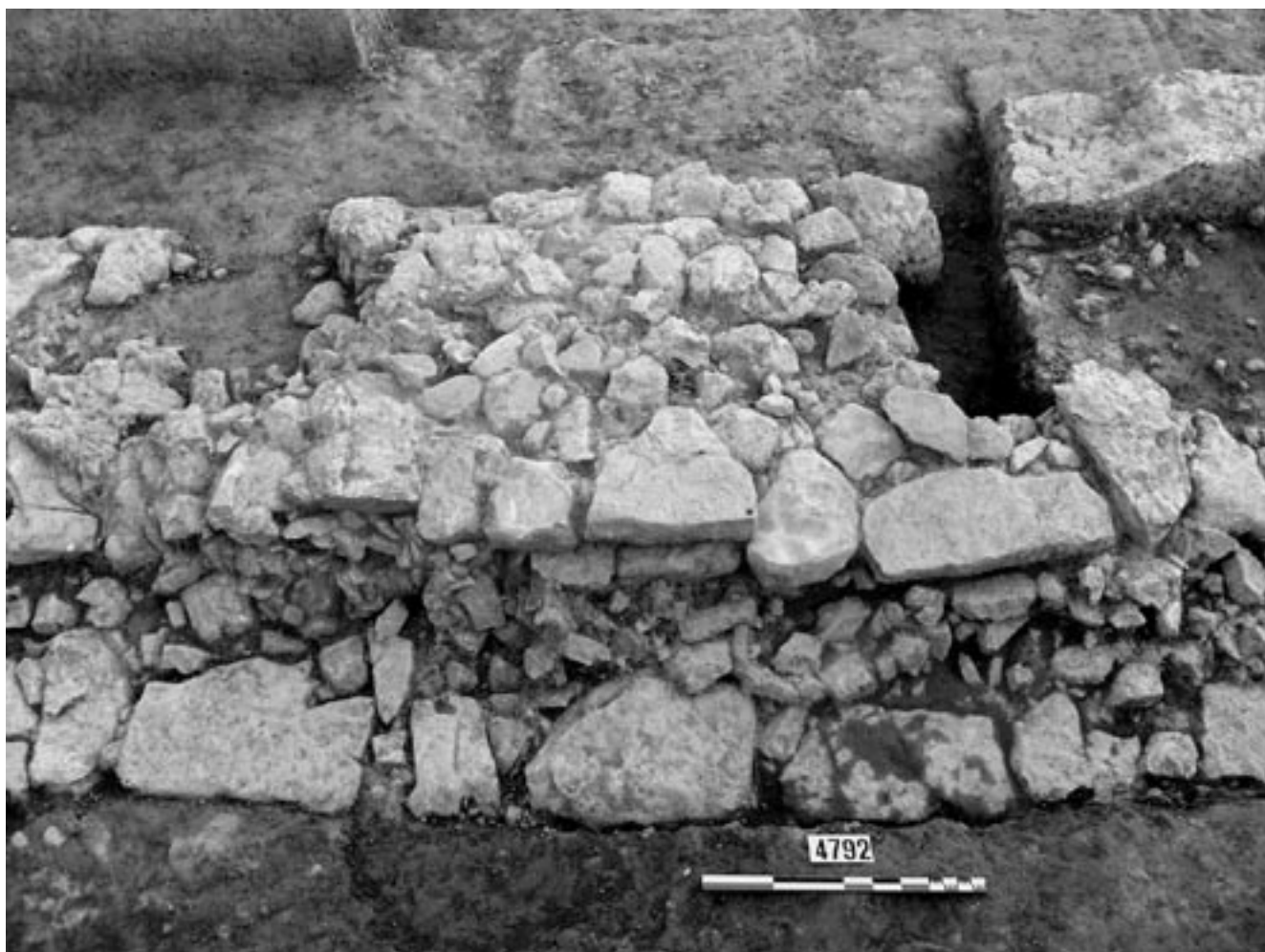
Fig. 42 : Vue des gradins qui forment les assises de fondation du mur de terrasse MR36231, prise du sud.
