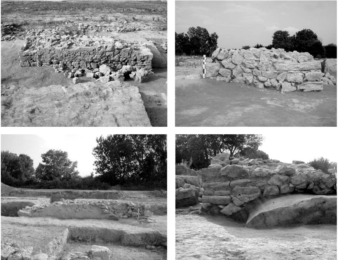
Fig. 31 : Détail des parements et de la partie postérieure de la tour T4.
