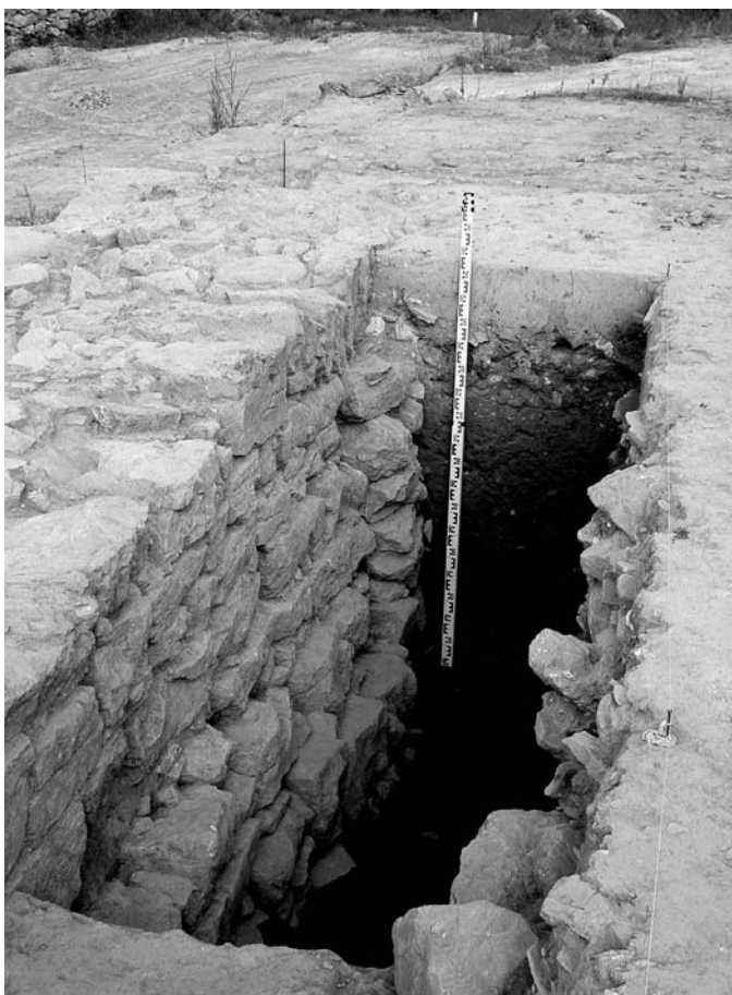
Fig. 15 : Détail du parement externe des avant-murs MR36082 et MR36084. Photo prise de l'ouest.
