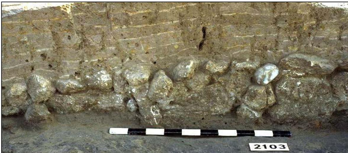
Fig. 30 : Mur nord de la pièce 4 [MR1323], vue prise du sud; base de pierre et élévation en adobes.
