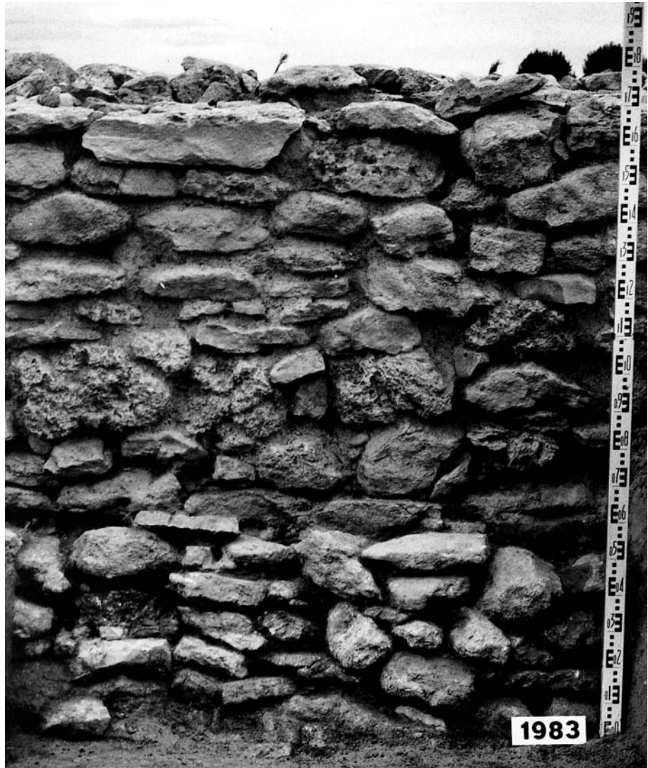
• 26 : Détail de l'élévation conservée du parement externe des deux murailles superposées (sondage "J"). Vu du sud. Cliché J.B. López.
