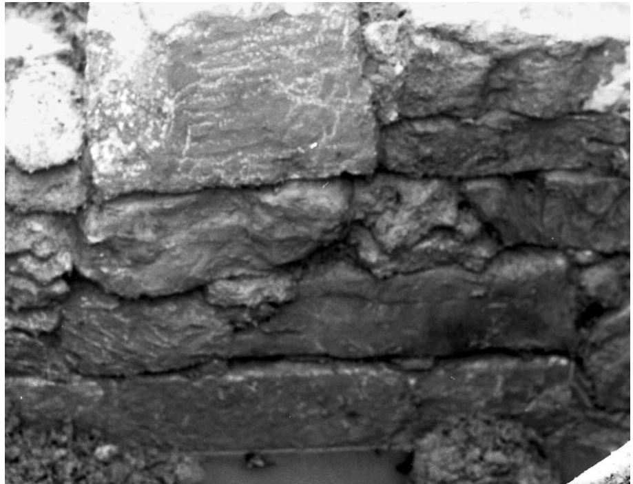
• 6 : Détail de la réfection dans le parement nord du mur M-1. Cliché H. Prades.
