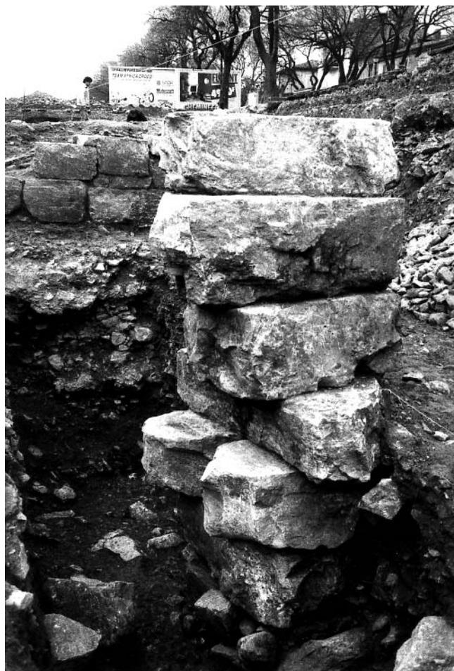
Fig. 240. Détail d'une des piles de fondation (Cliché M. Célié).
